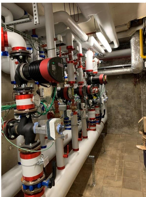
6 - Rénovation du collecteur au CEPES de Jodoigne
