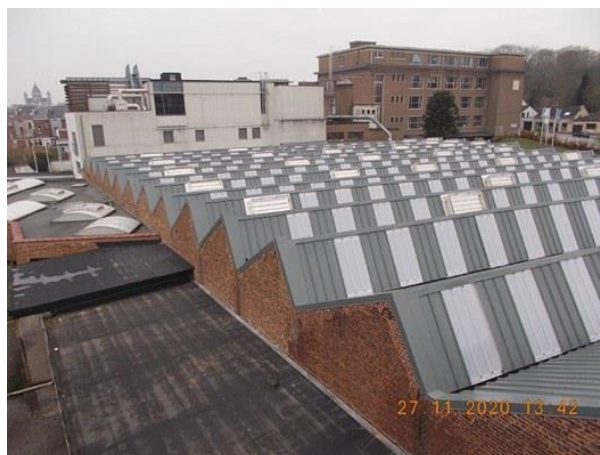
4 - Toiture en sheds des ateliers de l'IPAM
